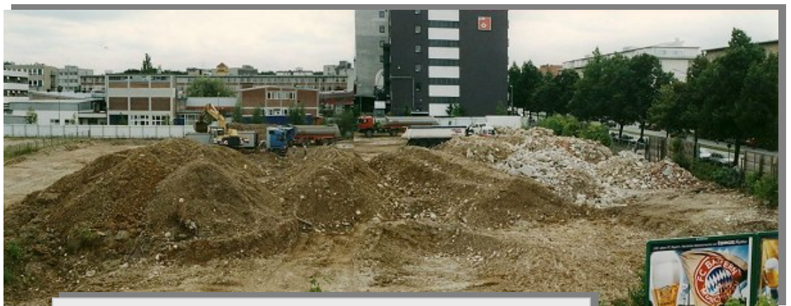
Abtransport der Boden- und Bauschutthalten zur Verwertung/Entsorgung
